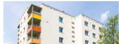
Sanierung Lomonossowallee 20 Baujahr 2014
