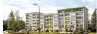
Sanierung Lomonossowallee 33/34 Baujahr 2015 - 2016
