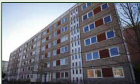
In der Anklamer Straße 78 werden die äußeren Abdichtungen und die Kellerabdichtungen realisiert. Außerdem ist der Austausch einiger Fenster, das Anbringen der Wärmedämmverbundsysteme an der zur Straße gelegenen Fassade, die Erneuerung der Elektrosteige- und Versorgungsleitungen sowie die Dämmung des Dachgeschosses geplant.
