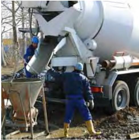
Mit schwerem Gerät begann die WVG mbH Greifswald im März den vierten Neubau innerhalb von drei Jahren in Schönwalde I/West. 52 Bohrpfähle wurden bis zehn Meter tief in die Erde gerammt und mit Beton ausgegossen, um den Neubau in der Einsteinstraße 21 auf sicheren Untergrund zu stellen. 14 neue Wohnungen werden bis Jahresende entstehen.
