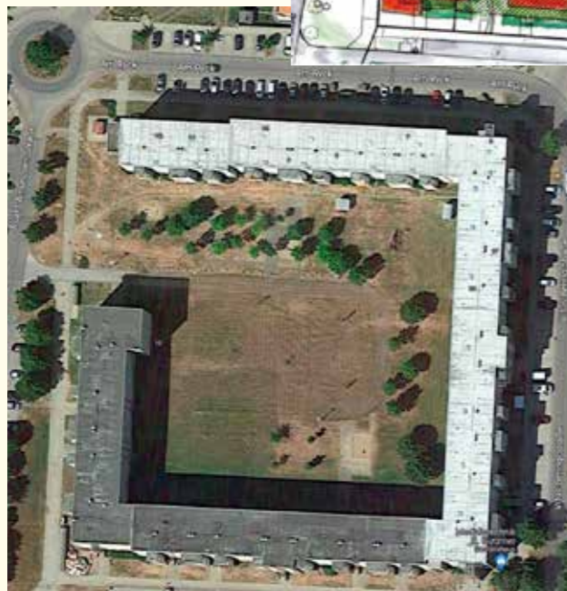
Aktueller Stand - dunkle Dachflächen: WVG Gebäude
