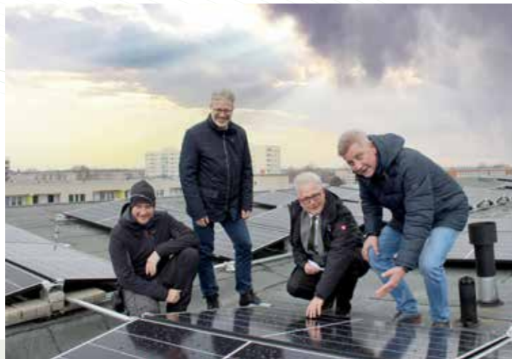
Die erste eigene Photovoltaikanlage wurde auf dem Dach der Heinrich-Hertz-Straße 20 installiert. Aufsichtsratsvorsitzender Alexander Krüger, Oberbürgermeister Dr. Stefan Fassbinder, WVG-Geschäftsführer Klaus-Peter Adomeit und Stadtwerke-Geschäftsführer Thomas Praulße (v. l. n. r.)
