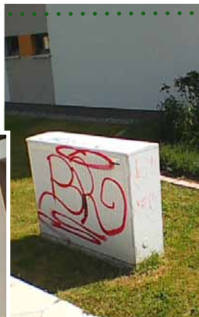
Selbst an unserem Neubau im Quartier „Wohnen am Stadtpark“ hat es bereits mehrere Beschmierungen durch Graffitisprayer gegeben.
