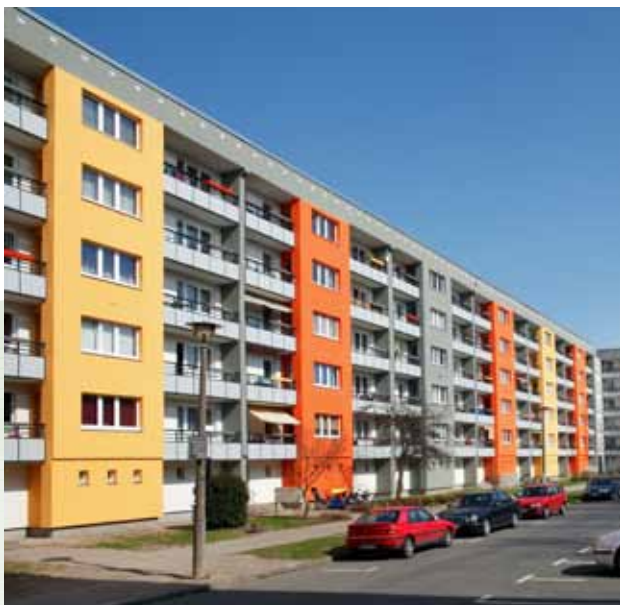
Umbau/Sanierung 2011: Vierower Wende 1 - 6
